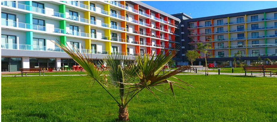
Fig 5: Showing South Façade and north Façade (Google=Neden Mağusa'da Pop Art Öğrenci)
